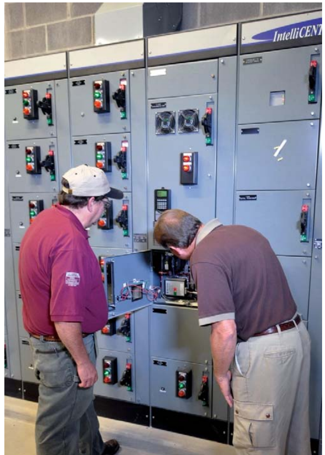
现有控制系统现在将旧设备中执行的操作镜像为“T”，所以，如果操作人员打开某个值并保持 15 分钟，新系统就会完成具体命令。
