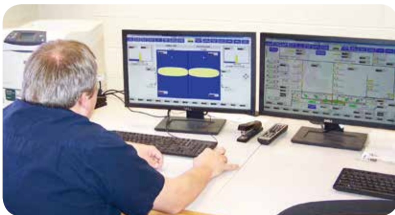
新系统采用罗克韦尔自动化 PlantPAx 过程自动化系统 - 集成控制和信息解决方案。
