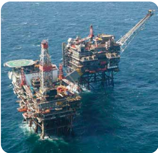
Alwyn North 包含两个平台(NAA 和 NAB)，这两个平台通过一座 73m 长的钢桥相连。NAA 是钻井和生活平台，而 NAB 则是安装过程设施的平台。
