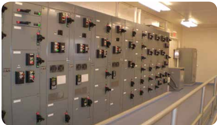
采用 IntelliCENTER 技术的 Allen-Bradley 智能电机控制器提供集成智能，可连接罗克韦尔自动化的 PlantPAx 过程自动化系统。
