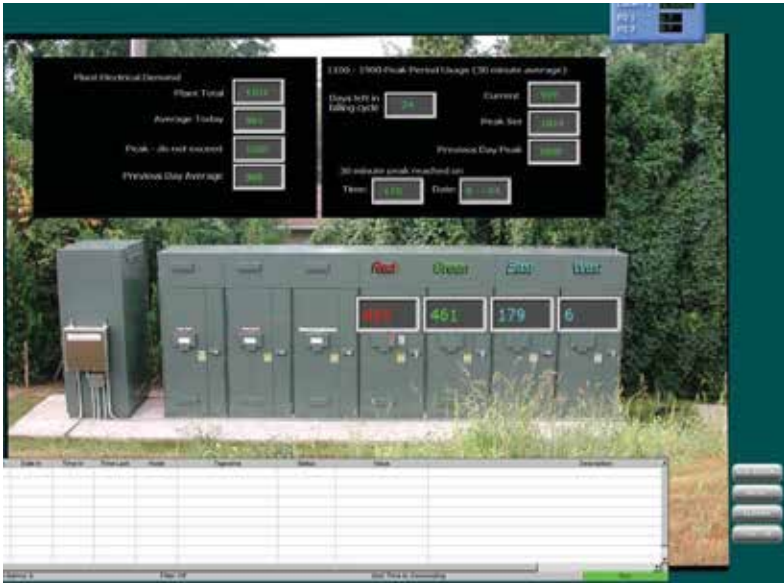
安娜堡购置了 Rockwell Software RSPower Plus 软件和四台支持以太网的 Allen-Bradley PowerMonitor 设备，这些设备可通过以太网连接到过程控制网络。
