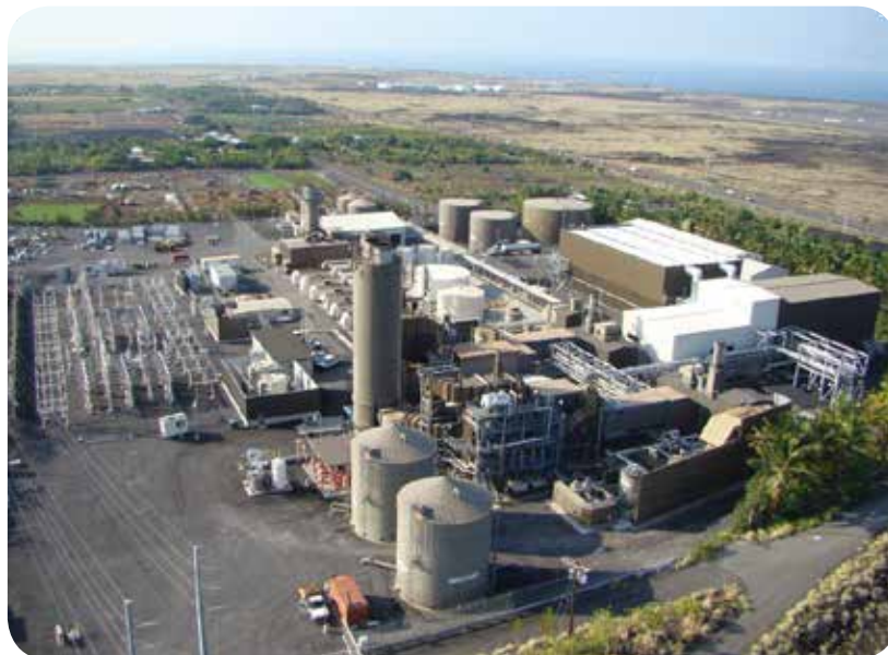
Keahole 电厂有三台燃气轮机，每年可产生大约 2.4 亿度电。
