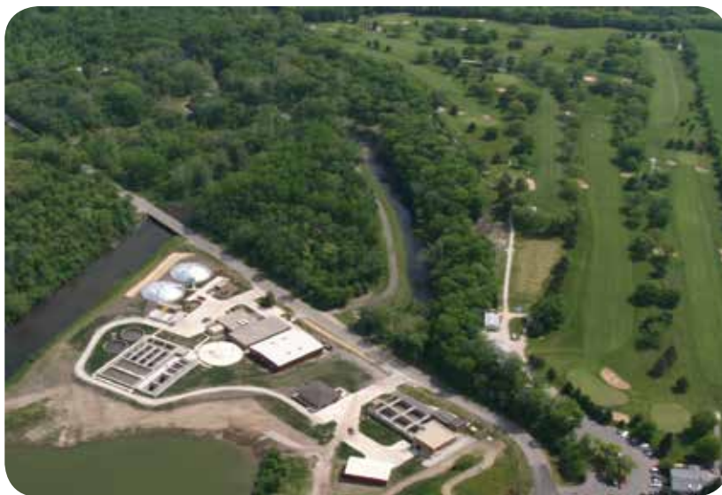
伊利诺伊州普莱诺，普莱诺市水处理厂
